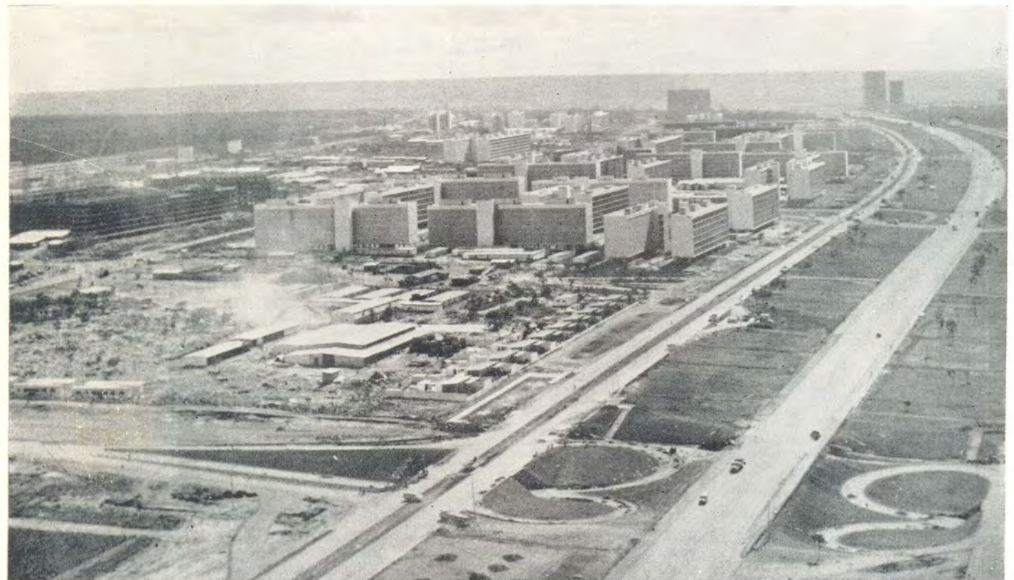
Foto aérea da curva do Eixo Rodoviário.
