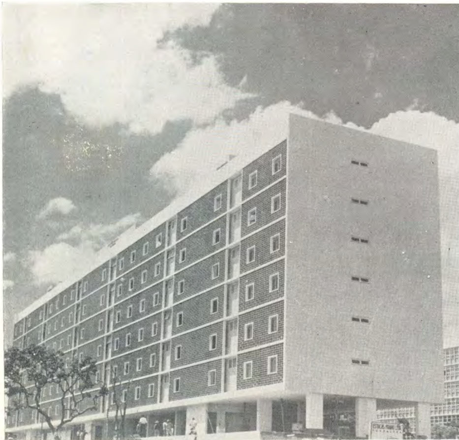
Edifício de apartamentos do IAPI.
