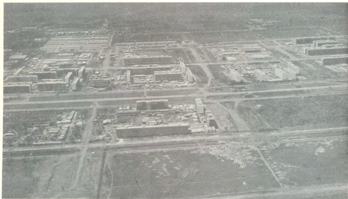
Vista aérea do Setor de Habitação das Super-Quadras.
