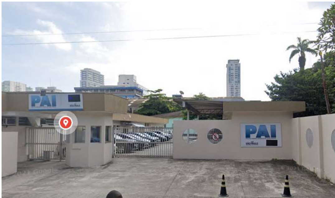
Acesso Avenida Siqueira Campos, s/nº
