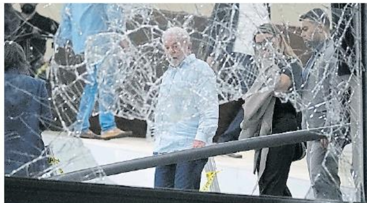
Lula inspeccionó anoche los daños al Palacio del Planalto
